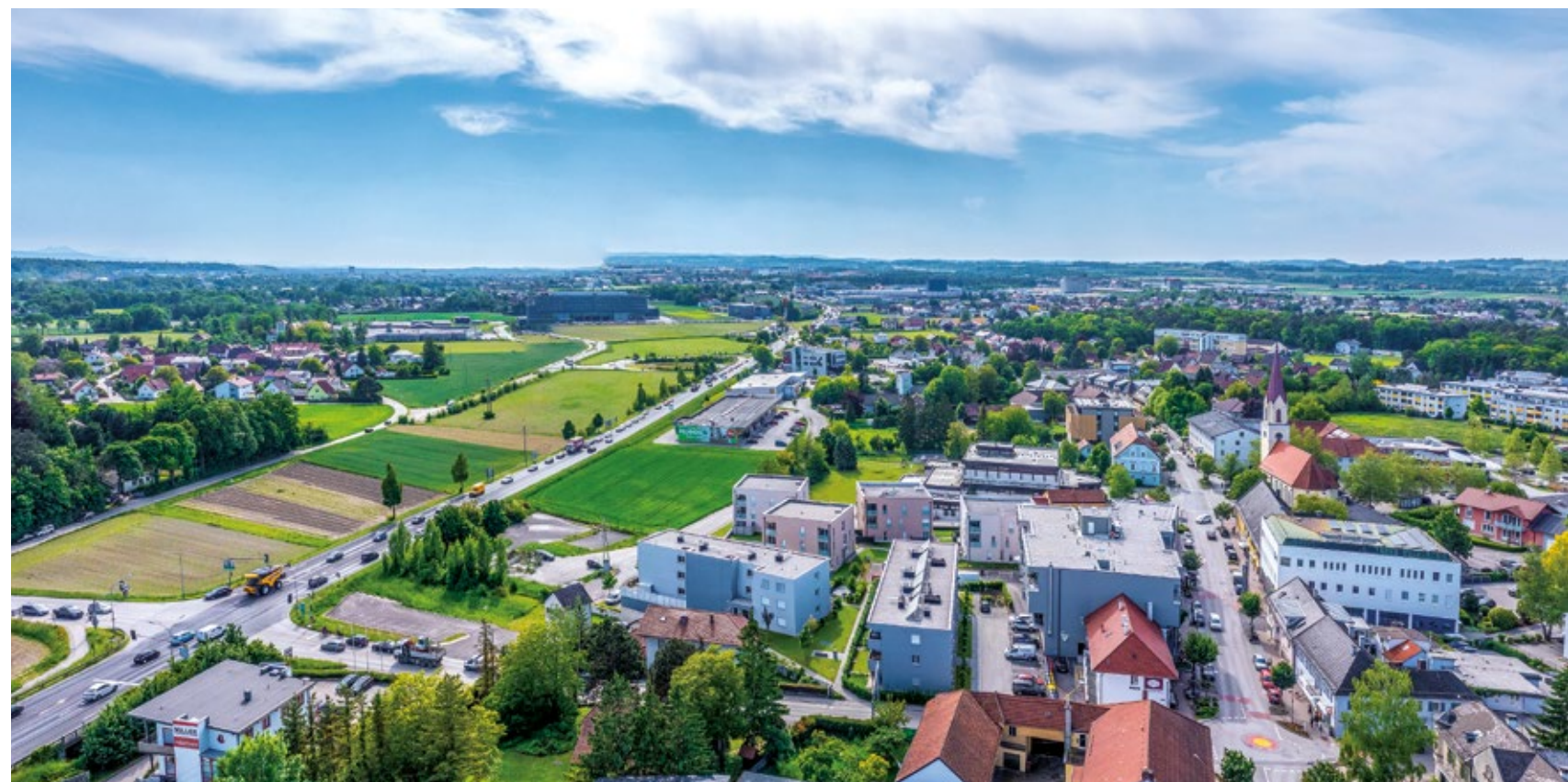
WOHNANLAGEN IM ZENTRUM VON MARCHTRENK
